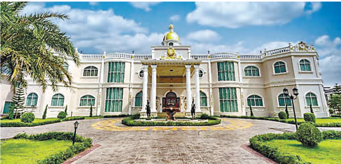
曼谷挽汶区豪宅别墅：被犯罪分子用作电诈园区。
