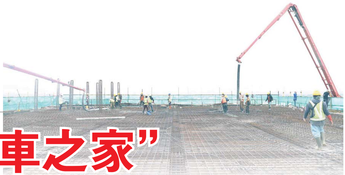
→ 动车组站房综合楼A楼封顶浇筑。
