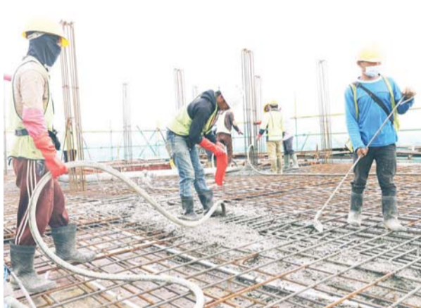
施工人員現場澆築振搗作業。
