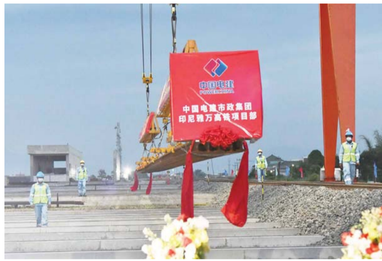
钢轨运抵德卡鲁尔动车所铺轨基地。
