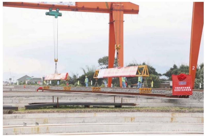
钢轨吊装转运。
