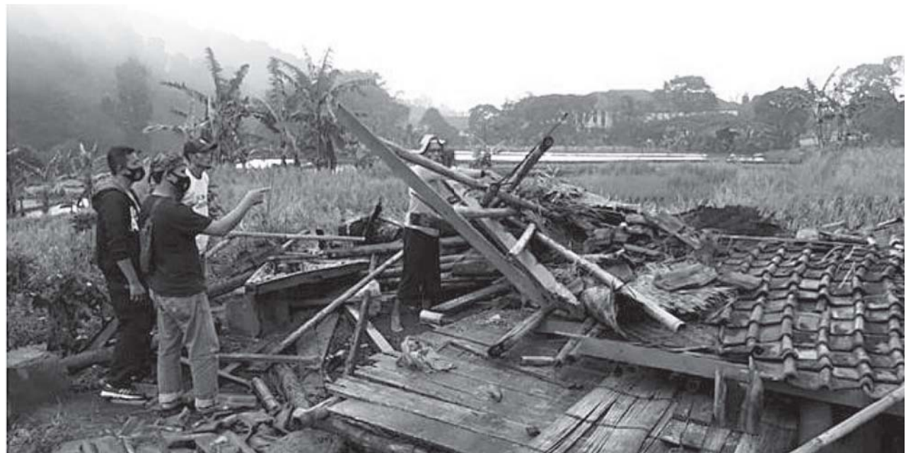
被強風驟雨吹塌的田邊小屋。
