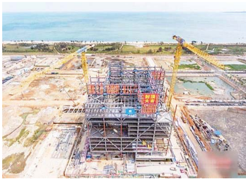
航拍海南国际能源交易中心钢结构封顶现场。
