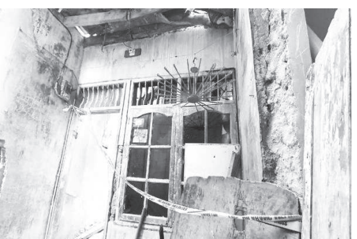
雅京西區卡里德勒斯地区房子突然坍塌的房子被围上警戒线。
