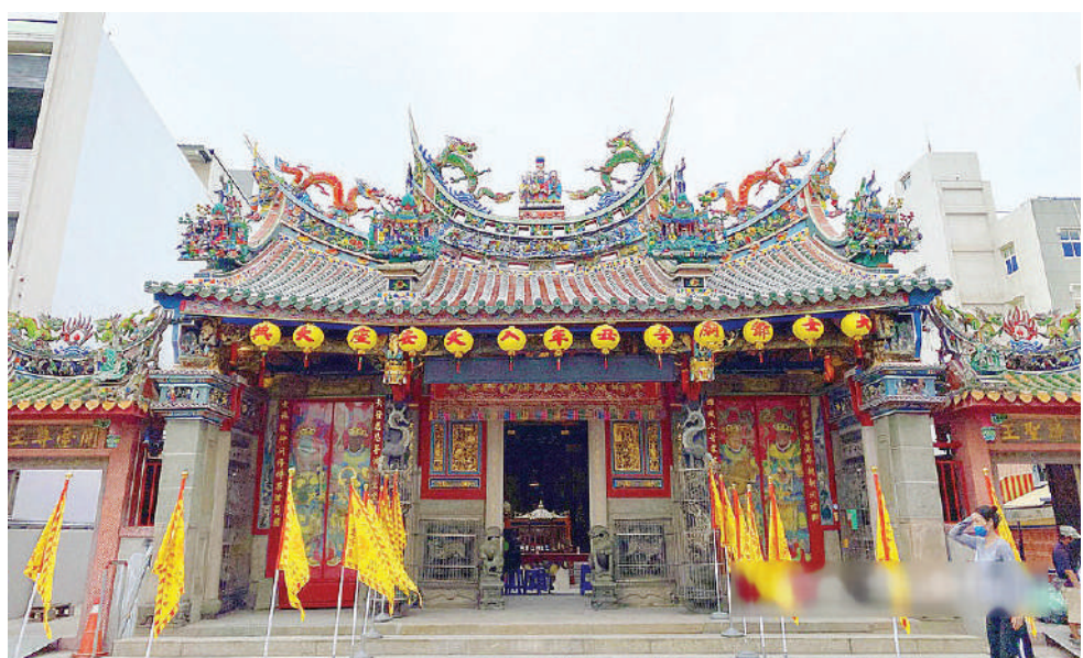
嘉義縣定古蹟民雄大士爺廟整修竣工。
