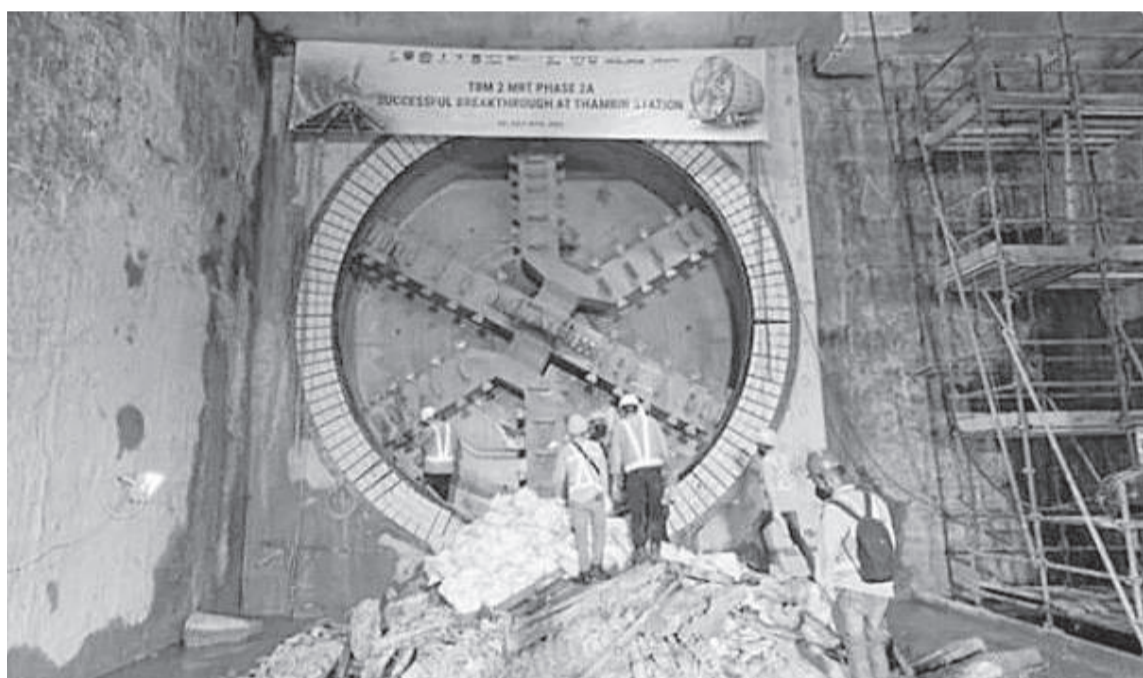
隧道钻挖机2在雅加达地铁(MRT)2A期建设项目。
