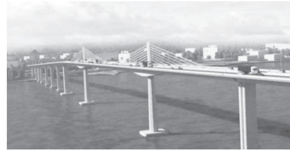
碑。达沃-萨马尔岛大桥是中菲政府间合作旗舰项目。大桥项目位于菲律宾南部棉兰老岛，横跨巴基普坦海峡，连接达沃市与萨马尔岛。大桥采用双向四车道设计，全长3.81公里，包括主通航孔桥、东西海上引桥、东西陆地引桥及达沃侧的互通匝道桥。
