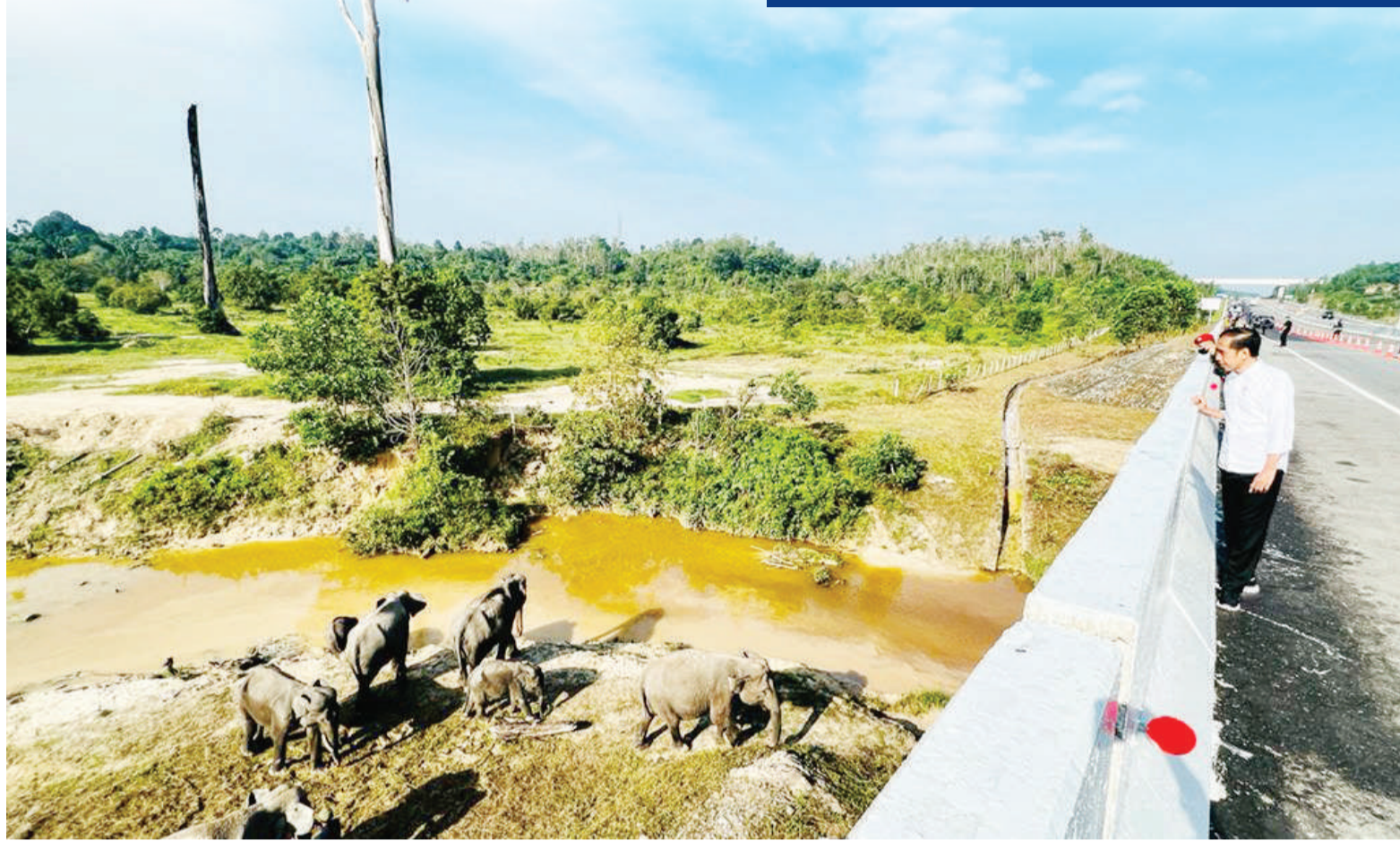
佐科威在北干峇鲁-都迈高速公路，目睹了一群大象在地下通道通行。
