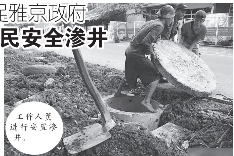
工作人员进行安置渗井。
