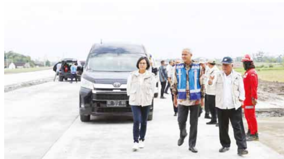
丝丽(左起)、甘查尔及峇苏基视察施工现场。
