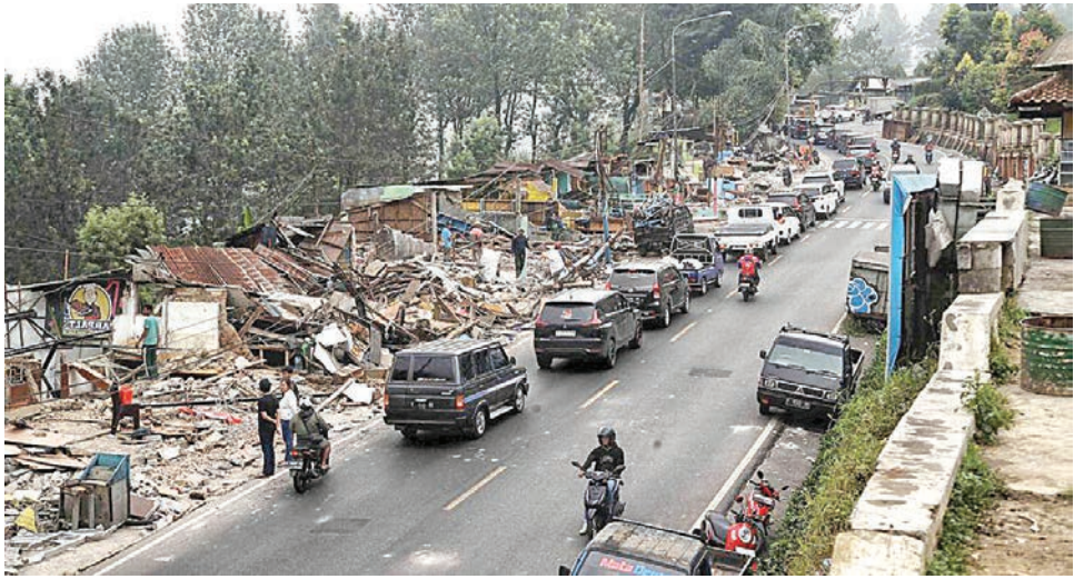
茂物县政府拆除本哲地区的331个商贩摊位。
