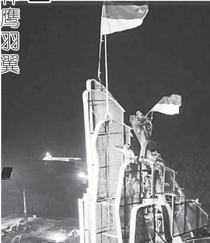
新首都总统府神鹰羽翼安装完毕。
