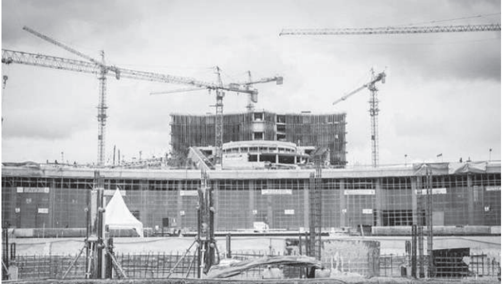
新都第一批基建已完工。
