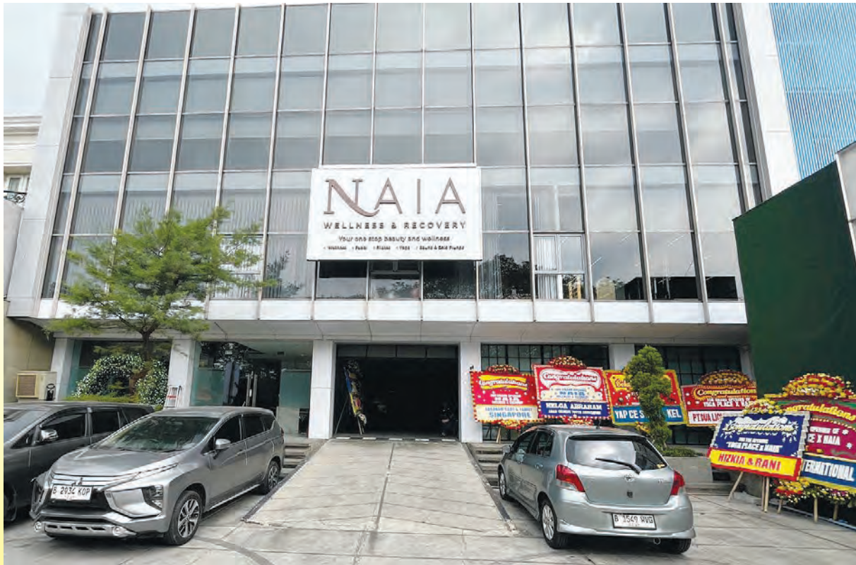
Naia Wellness & Recovery大厦外观。
