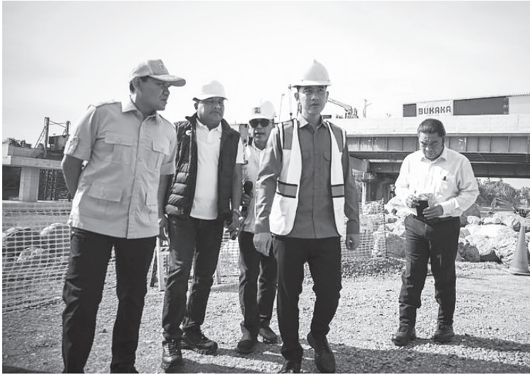
吉布兰检查克鲁恩丁克姆大桥的重建进展。
